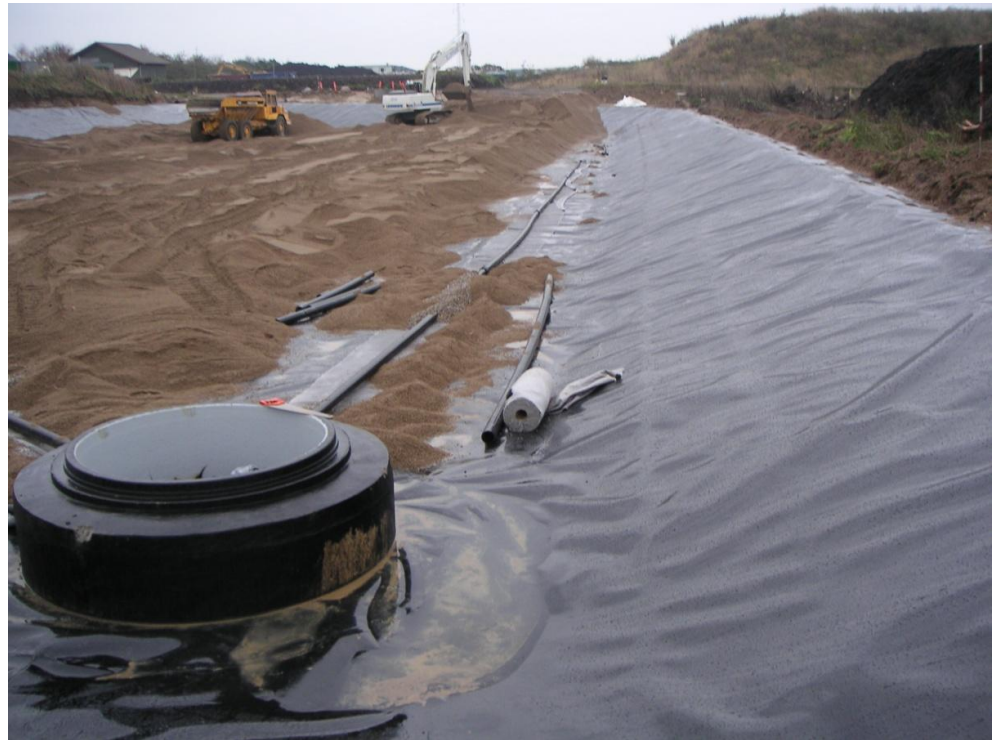
Պատկեր 29 Բարձր խոռոչյան պոլիէթիլէնի վրա 0.25 մ դրենաժայի ն շերտի տեղադրում
